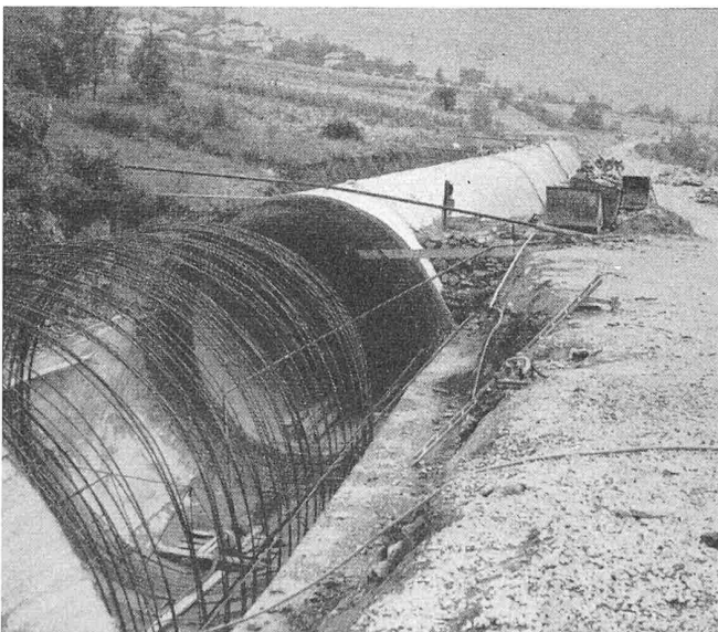
Bild 46. Die Druckleitung \varnothing 6,4 m aus Eisenbeton
