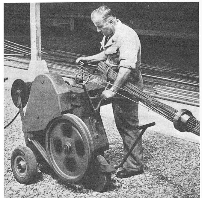
Bild 15 (links). BBRV Anker B125, bestehend aus 42 Drähten \phi 6 mm, für 125 Tonnen Vorspannkraft
