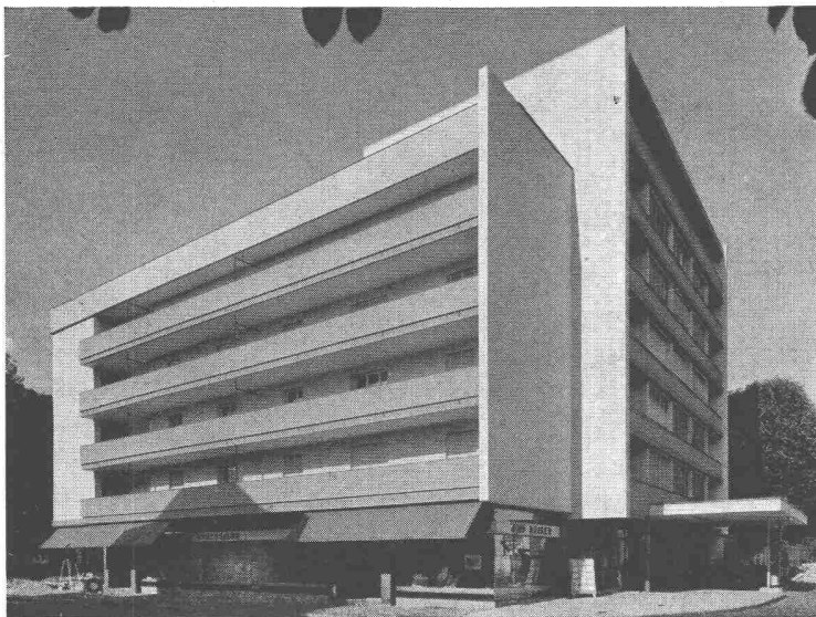
Farbenkonditionierung beim Fassadenanstrich
