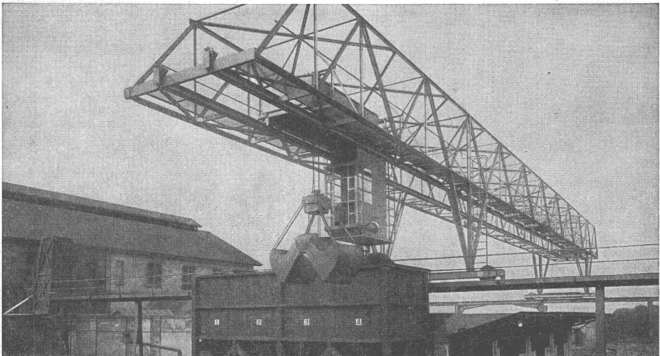
Verladebrücke in Schweisskonstruktion 2,5 t Tragkraft, 46 m Länge
