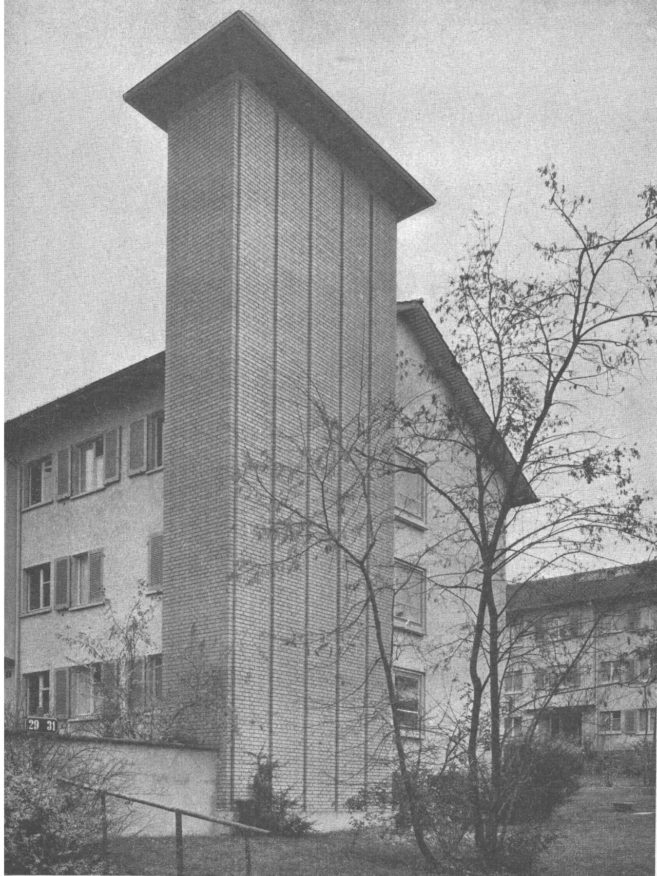
5-Züger Kamin einer Heiz- und Warmwasserzentrale
