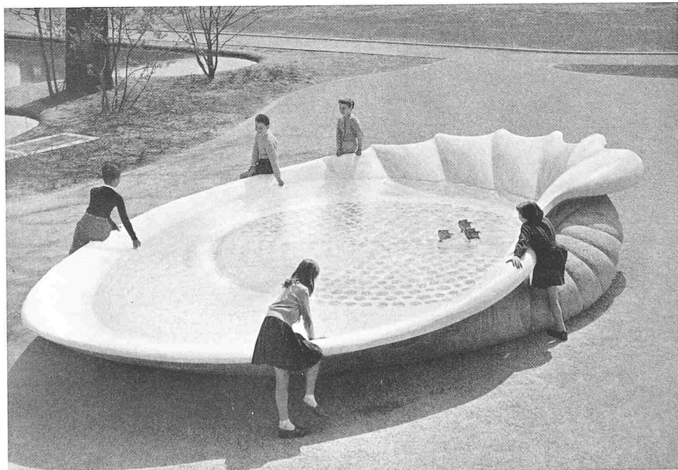
Coquille géante dans le préau central. Le fond de la coquille en béton translucide éclaire le hall de l'aula
