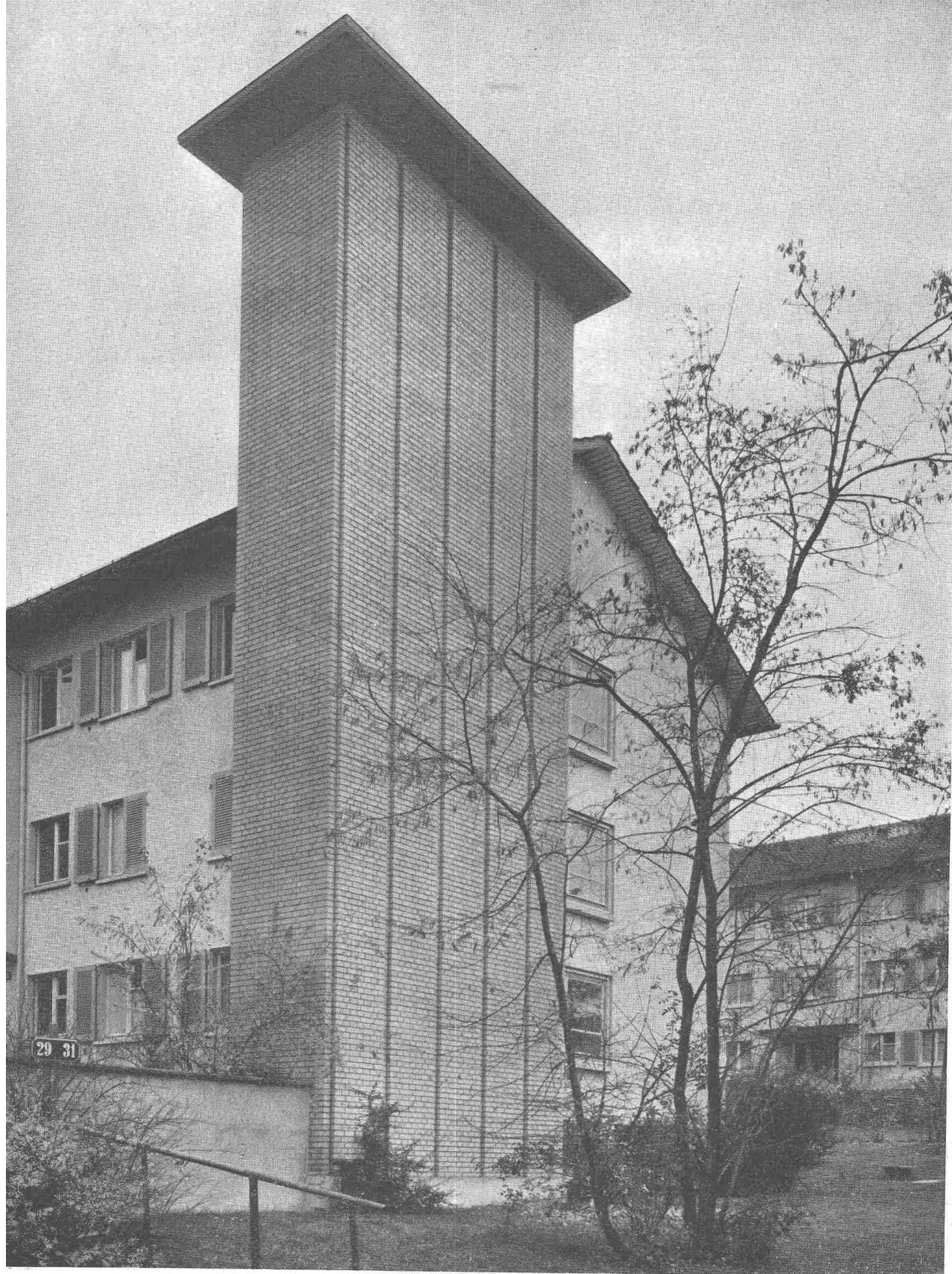
5-Züger Kamin einer Heiz- und Warmwasserzentrale
