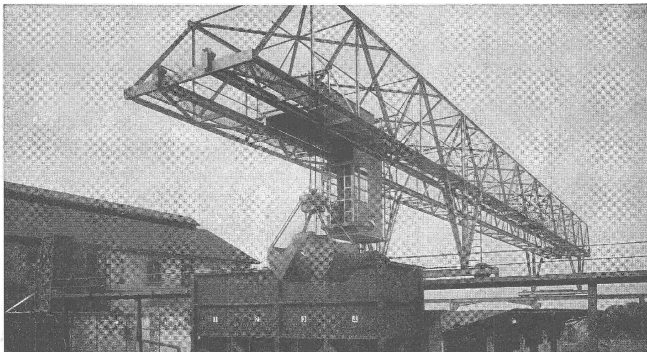
Verladebrücke in Schweisskonstruktion 2,5 t Tragkraft, 46 m Länge
