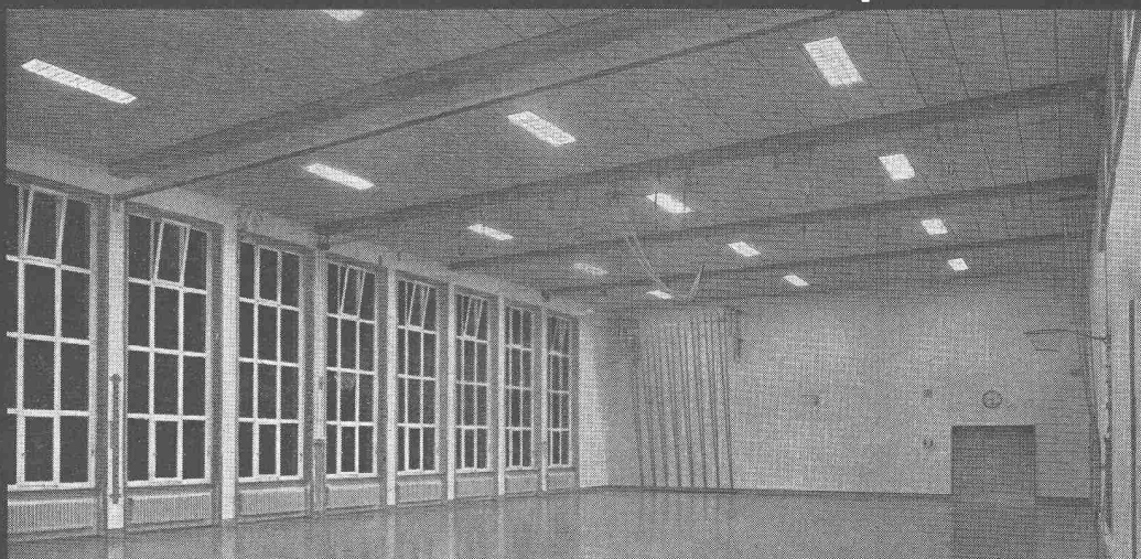
Ein Beispiel einer Turnhallenbeleuchtung
