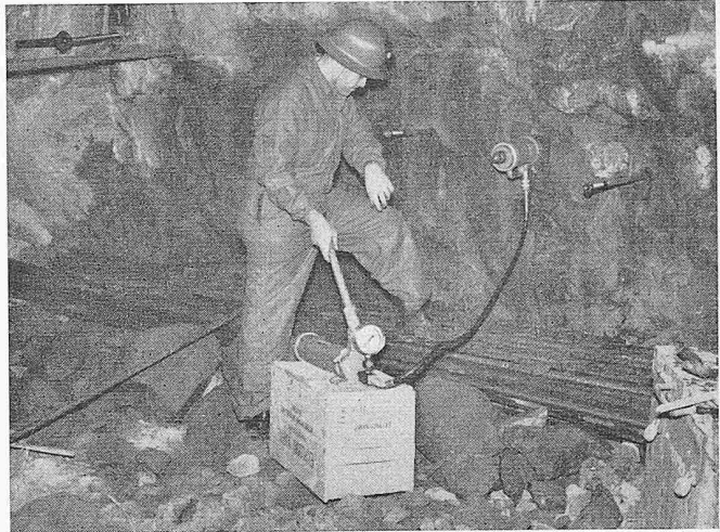
Bild 17. Zugversuche mit Perfoankern von 35 cm Ankerlänge, Nockenstahl \phi 19 mm in Granit. Mörtel mit «Perfo Sika» versetzt. Zugfestigkeit nach 1 Stunde 8 t
