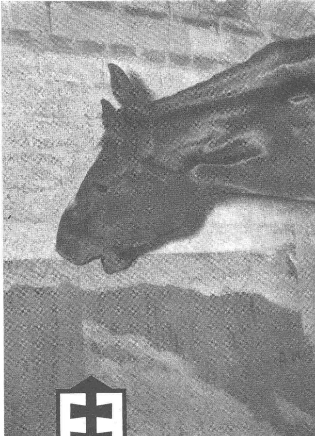
«Die im Februar 1953 mit BRIGATEX P auf Backsteinmauer verlegte Wandverkleidung aus Holzfaserplatten (halbhart, 6 mm) in einem Pferdestall ist inzwischen von den Pferden teilweise bis auf 1 mm abgenagt worden, ohne dass sich die Verleimung gelöst hätte.
