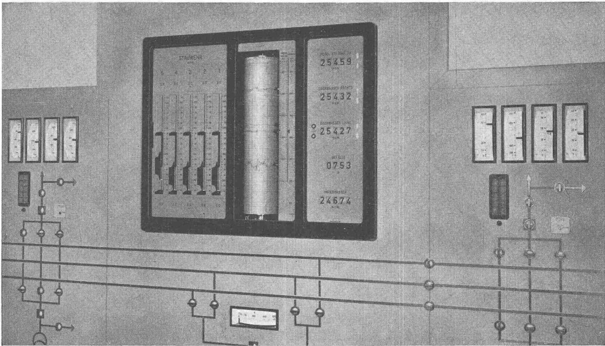
**Kraftwerk Birsfelden 80 000 kW** Bildmitte: Im kombinierten Empfänger sind angezeigt: die Stellung der Wehrschützen; angezeigt und registriert sind Oberwasserstand Steinhölzli, Stauspiegel linkes und rechtes Ufer, Unterwasserstand und Gefälle — Tendenz der drei Oberwasserspiegel — Alarm bei kritischem Stauspiegel linkes Ufer.
