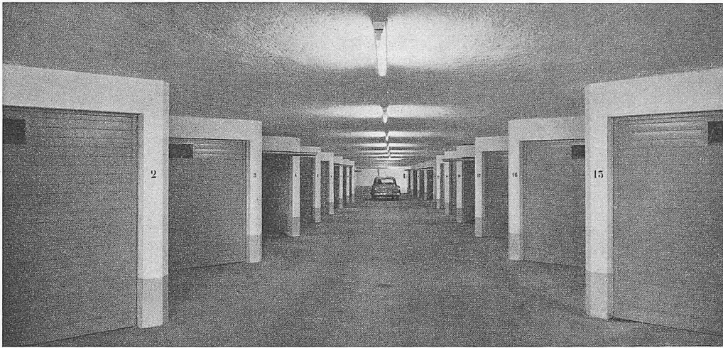
Die unterirdische Garage mit 26 Einzelständen
