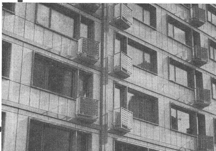
Ausfachung eines Beton-Skeletthauses
