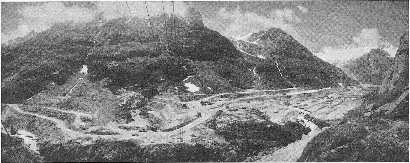
Bild 4. Sperrstelle und Staugebiet. Im Vordergrund der Aushub im Bereiche der Dammxasse, damit der Dichtungskern auf den Fels abgestellt werden kann. Das Aushubmaterial, das für den Dammbau wieder zur Verwendung kommt, wird im zukünftigen Staugebiet auf Zwischen-deponie gelegt. Im Hintergrund rechts ist ein Teil des Fangdammes zu erkennen.
