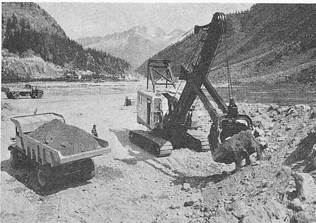
Bild 1. Bagger P&H 1055, 318 PS, 90 t, Löffel 2,7 m 3 . Links Rückwärtskipper 31 TD, 300 PS, beladen 40 t, Mulde 12 m 3
