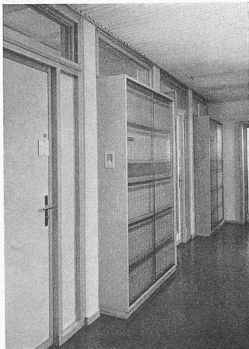
Gangpartie mit demontablen Elementen
