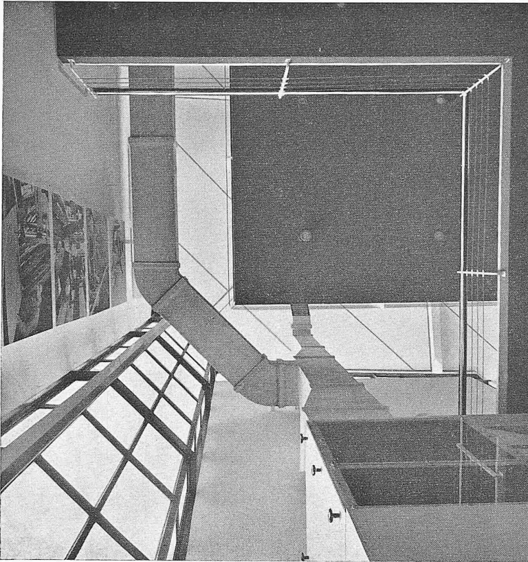
Vertikaler Blick nach oben in der Ausstellungshalle
