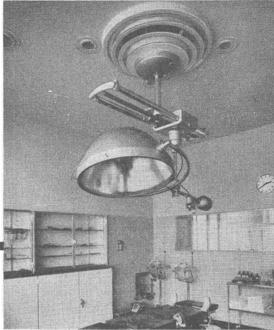
Klimaanlage «System Häusler» in Operationssaal eines Spitals
