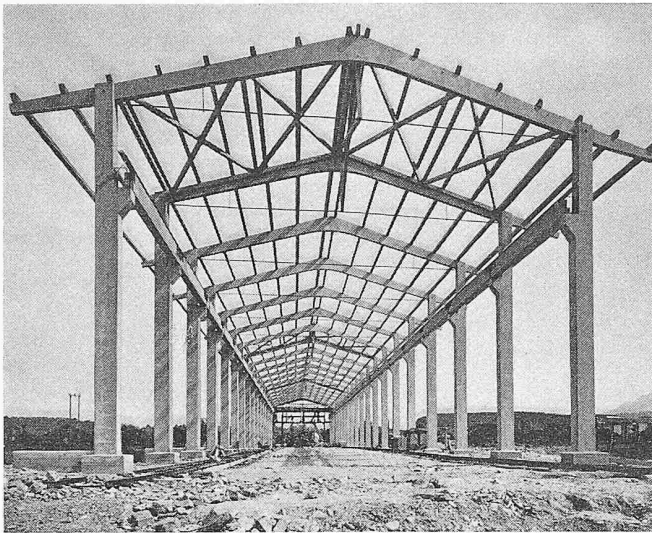
Bild 5. Werkhalle der Bauunternehmung Gebr. Brun in Emmenbrücke
