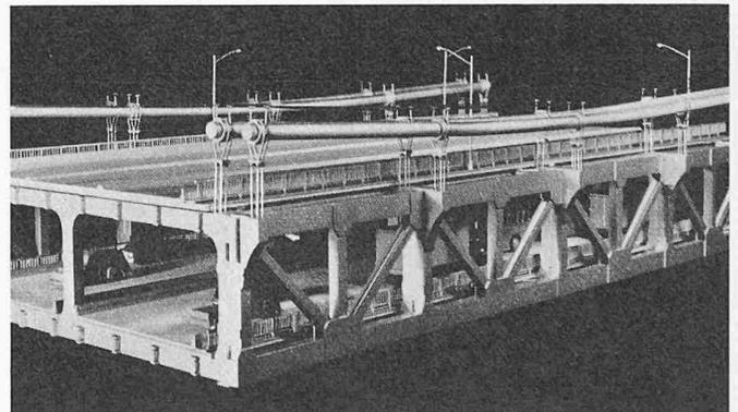
Modell eines Stückes der Fahrbahn mit Tragkabeln der Narrows-Brücke
