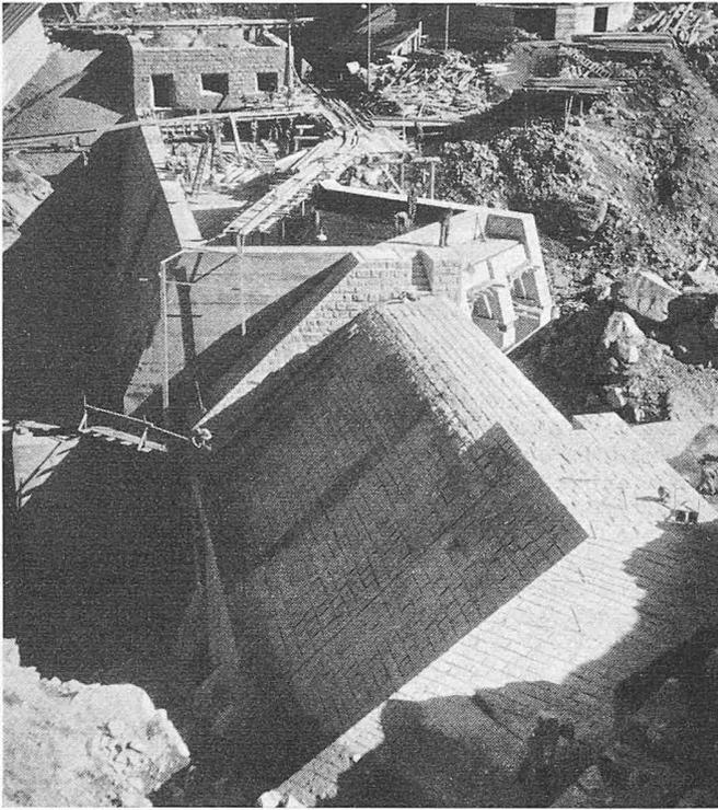
Bild 15. Triftwasserfassung im Bau, gesehen vom linken Ufer
