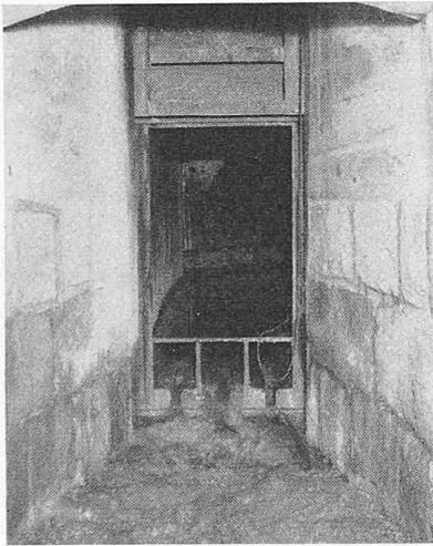
Bild 18 (links). Spülkanäle mit hochgezogenem Spülschieber (s. Schnitt c-c, Bild 14), gesehen vom Auslauf
