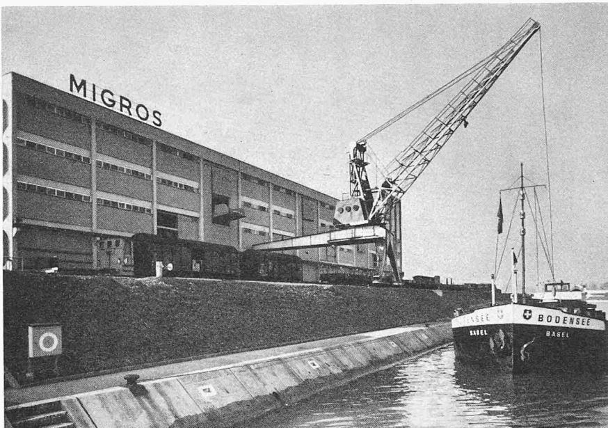
Bild 1. Das Migros-Kühlhaus am Rheinhafen Birsfelden
