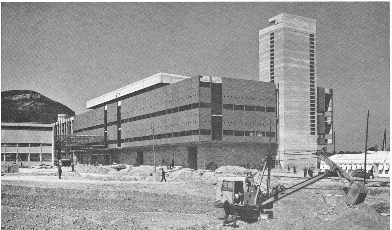
Bild 15. Das Gebäude der Plutonium-Gewinnungsanlage im Bau.
