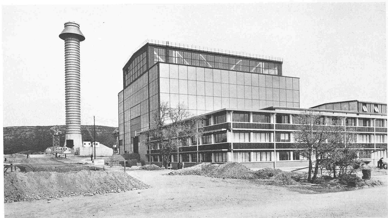
Bild 7. Das Gebäude des Reaktors G_1 , davor die Gebäude für die Hilfsanlagen, links der Hochkamin von 100 m Höhe.
