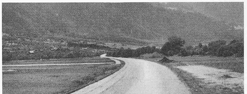
Bilder 5a und b: wie Bilder 4, aber ab Profil 80. Man bemerke die optische Kuppe. Aus baulichen Gründen konnte man leider nicht immer genau jene Standorte zur Photographie beziehen, die der Zeichnung zugrunde gelegt worden waren.
