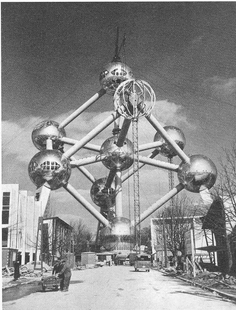
Das «Atomium» kurz vor seiner Vollendung (die Stützen aus Fachwerk dienen nur zur Montage). Gesamthöhe 102 m, Durchmesser der Kugeln 18 m, der Rohre 29 m, Länge der Rohre 29 m, Gerüst Spezialstahl, Verkleidung Aluminium. Das Innere der Kugeln und Rohre ausgenützt zu Ausstellungen über Probleme der Atomtechnik, in der obersten Kugel die Aufzugsmaschine «Schlieren», ein elegantes Restaurant und ein ringsumlaufender Aussichtsgang, in einer der untern Kugeln ein Bierlokal
