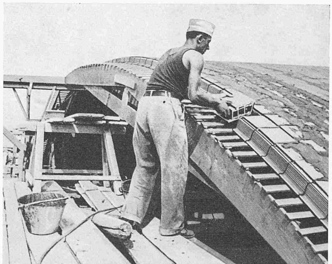
Bild 15. Ausführung der Schale mit einer beweglichen Lehre
