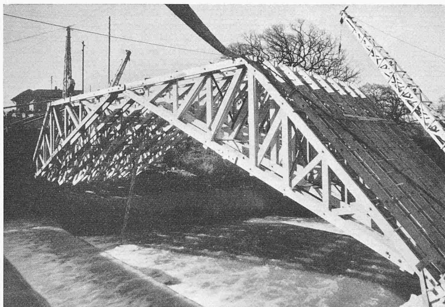
Bilder 7 und 8. Lehrgerüst in Ringdübelkonstruktion, Dreigelenkfachwerk von 35 m Spannweite; Binderhälften mit Holzderrick eingeschwenkt
