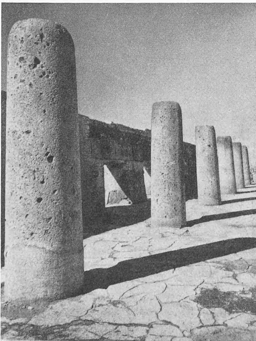
Bild 5 (unten). Inneres des Säulensaales von Osten. Trachytsäulen, cementartiger Boden.
