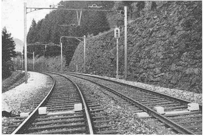
Bild 6. Impulsgeber für Achszählung an der Blockstelle einer zweigleisigen Bahnlinie
