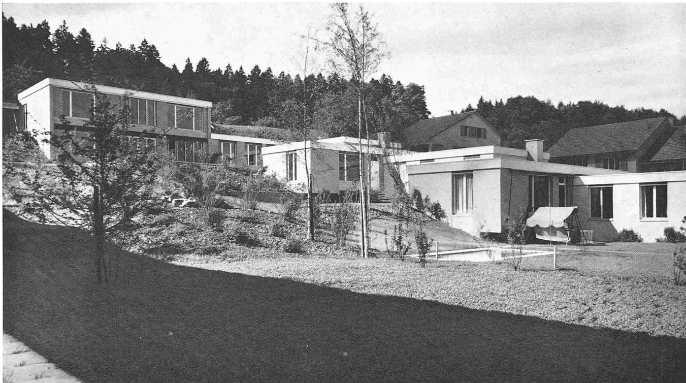
Blick in den Gemeinschaftshof gegen die 1. Etappe, aus Süden
