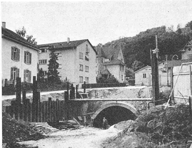
Bild 14. Baustelle Bahntunnel Obere Bahnhofstrasse (Foto D. Schüle, Zürich)
