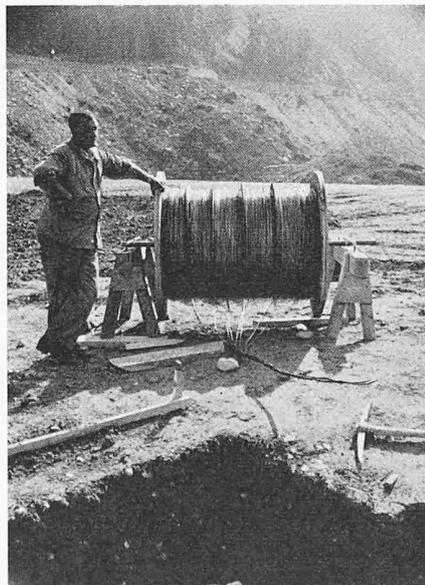
Bild 7. Kupferröhrchen der Druckzellen, bereit zum Auslegen in die Gräben.
