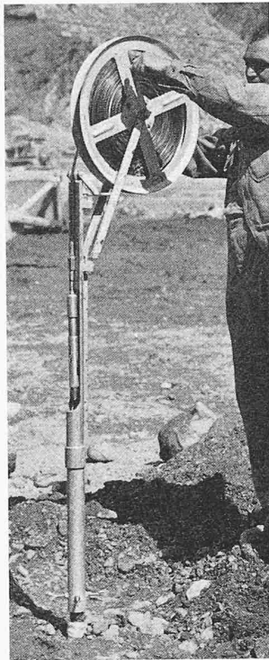
Bild 12. Auf dem Setzungspegel aufgesetzte Messeinrichtung. (Photo Brügger)
