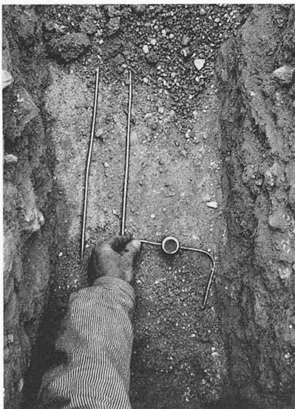
Bild 5. Piezometerdruckzelle vor dem Einbau in der Kernzone.
