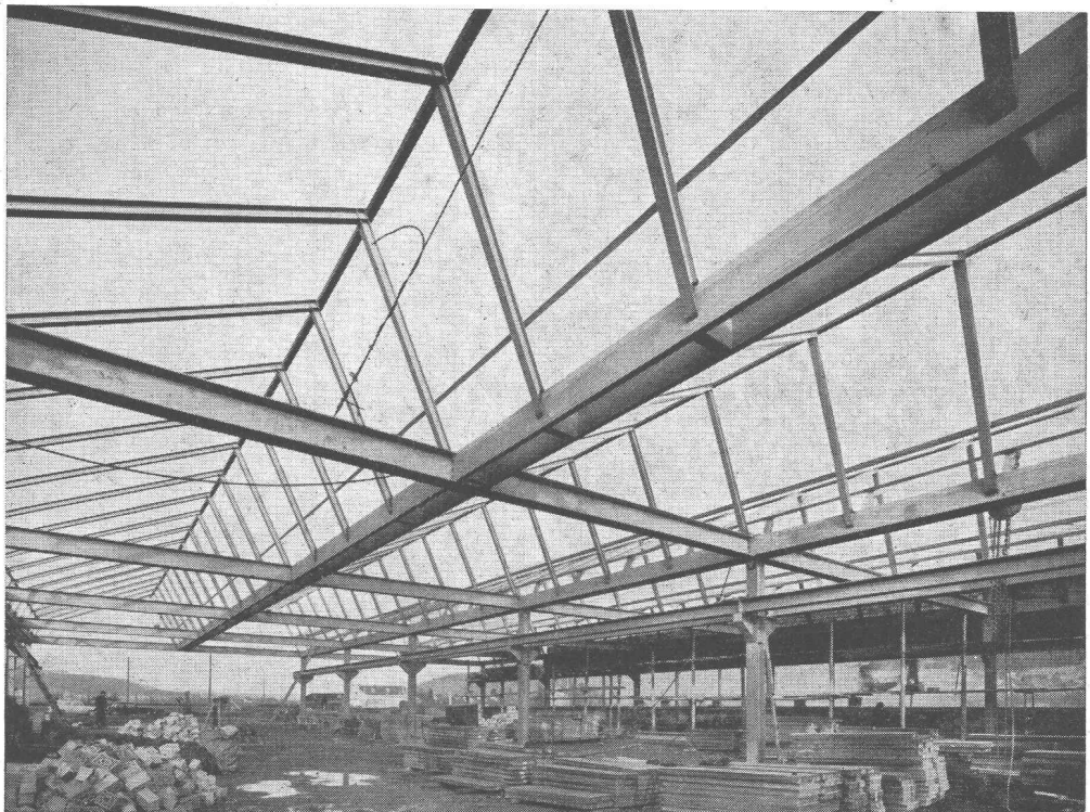
Shedbau, vollständig geschweisst
