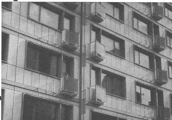
Ausfächung eines Beton-Skelettbau
