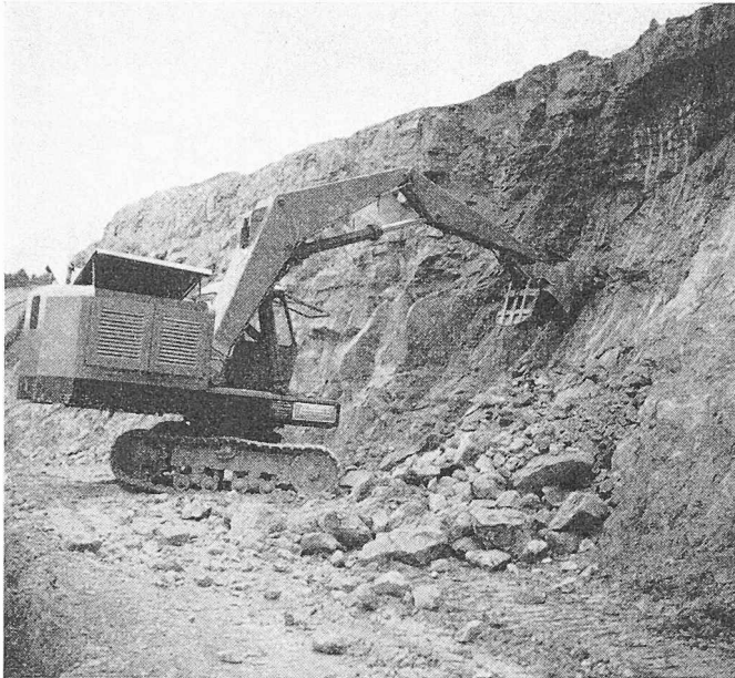
Bild 3. Abbau des Tonmergels mit hydraulischem Bagger
