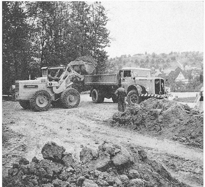
Bild 4. Beladen des Lastwagens mit Pneuladeschaufel
