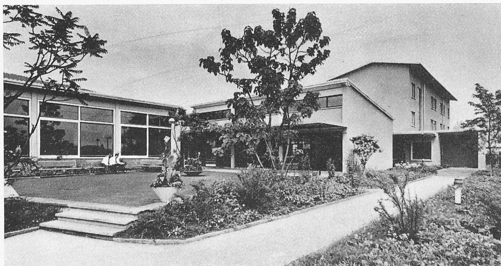
Bild 35. Links Theoriesaal der Bahndienstschule, in der Mitte die Werkkantine mit Leichtmetall-Sonnenschutz, rechts Eingang zum Logierhaus der Bahndienstschule
