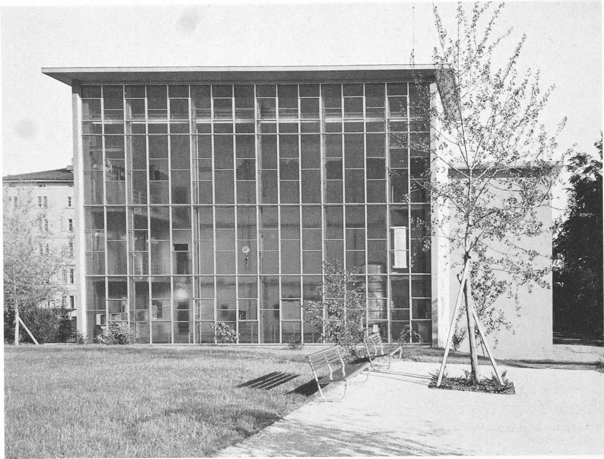
Das neue Physik-Institut der Universität Zürich, Grosslabor an der Nordseite Architekten Hächler und Pfeiffer, Zürich
