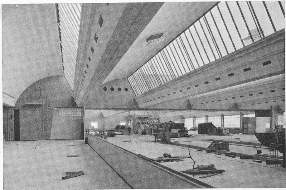
Bilder 12 und 13. Textilfabrik Schild AG in Bern. Grundrissfläche von rund 5000 m 2 , nur eine Stütze in Hallenmitte, vorgespannte Shedschalen von rund 36 m Spannweite, welche auf einem Kastenträger ruhen
