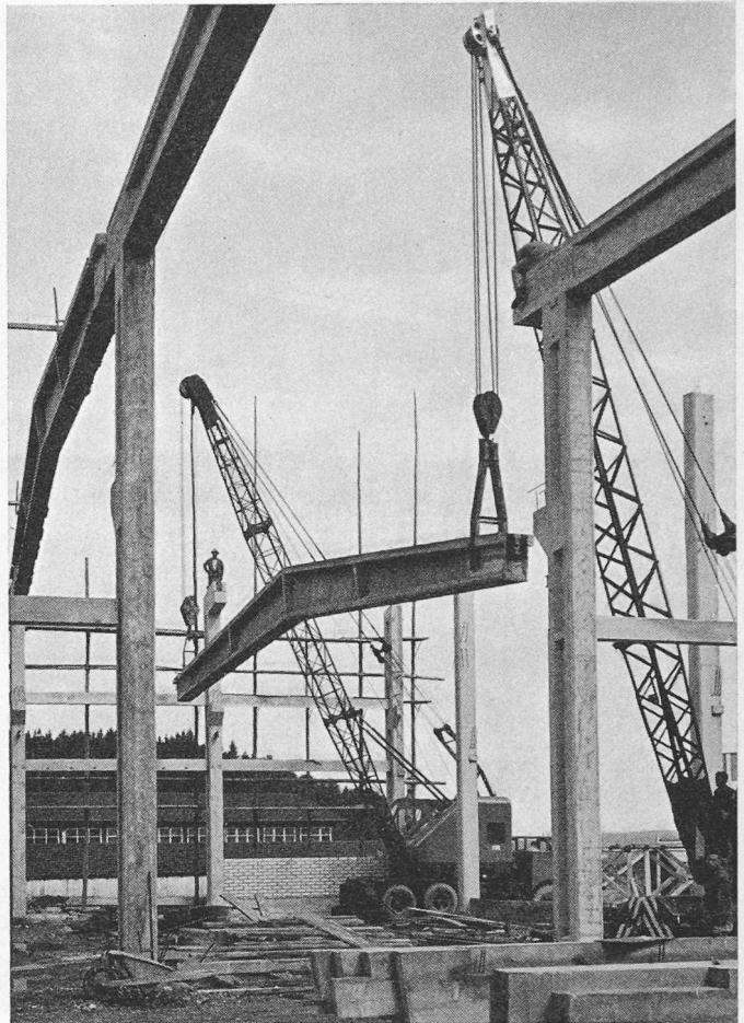
Bild 24. Versetzen eines vorgespannten Riegels
