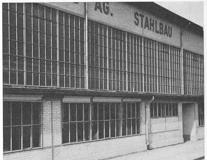
Bild 8. Werkhalle Gebr. Tuschmid AG., Frauenfeld
