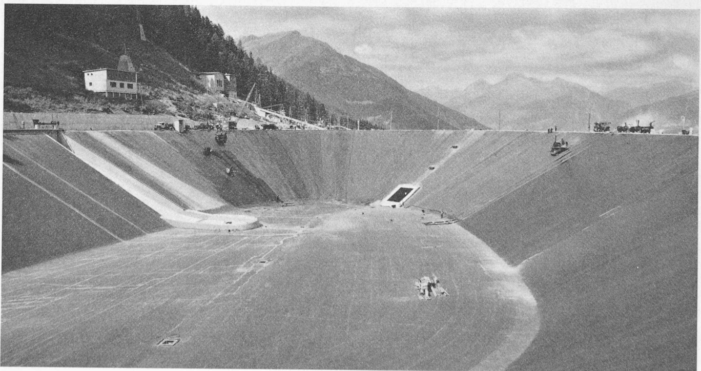
Bild 4. Ausgleichbecken Rosswiese der Oesterreichischen Draukraftwerke
