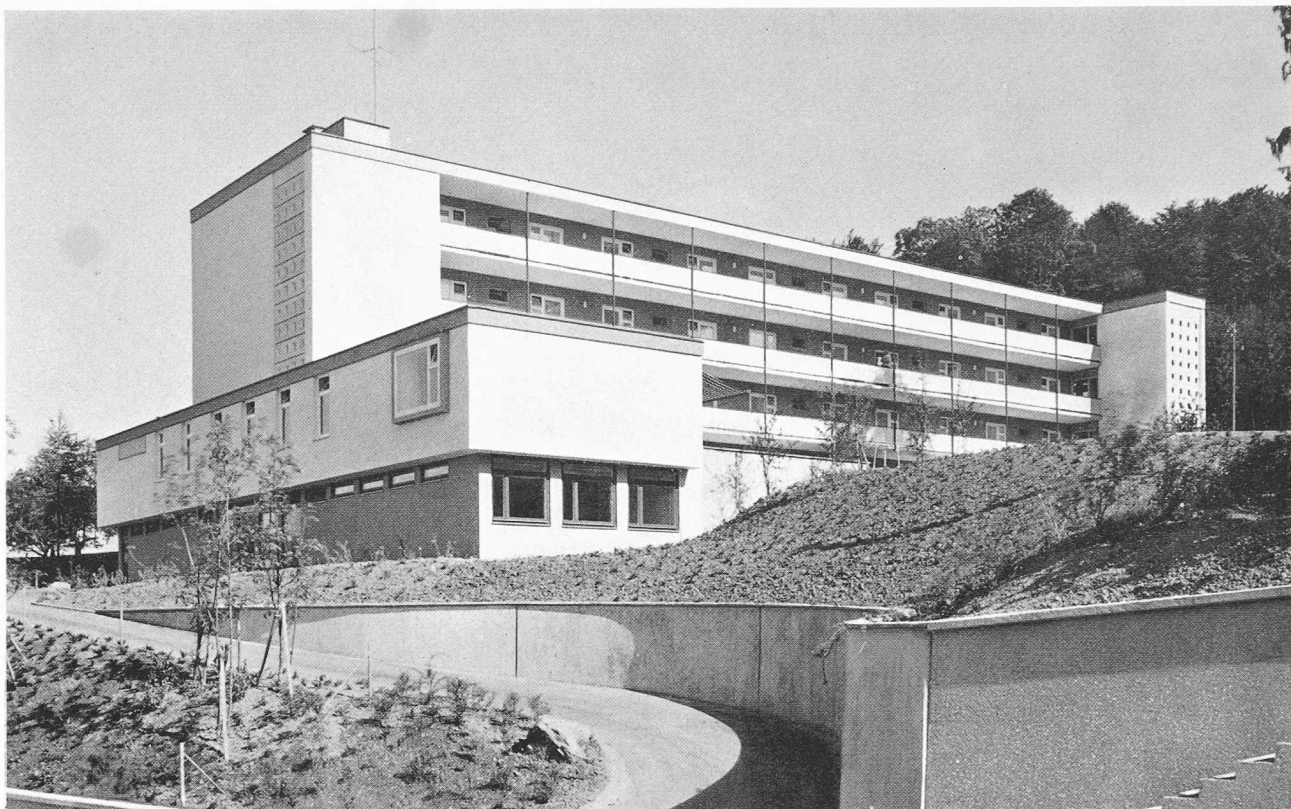
Die Alterssiedlung Waldgarten aus Nordwesten, mit Zufahrt von der Frohburgstrasse her
