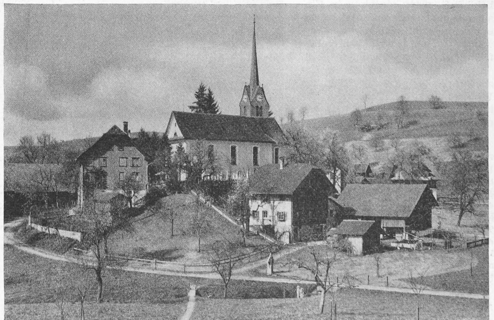
Bild 4. Pfarrkirche Geiss in Menznau von Südwesten vor dem Umbau von 1952
