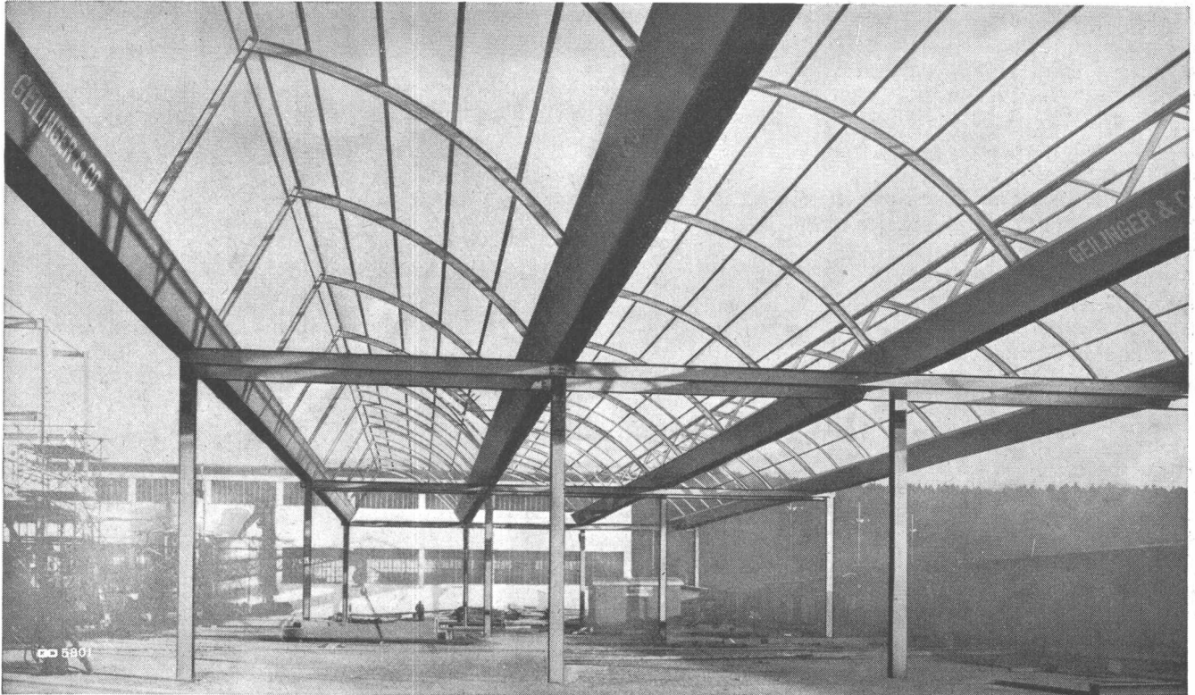
Shedkonstruktion mit rinnenförmigen Hauptträgern (+ Pat. angem.)
