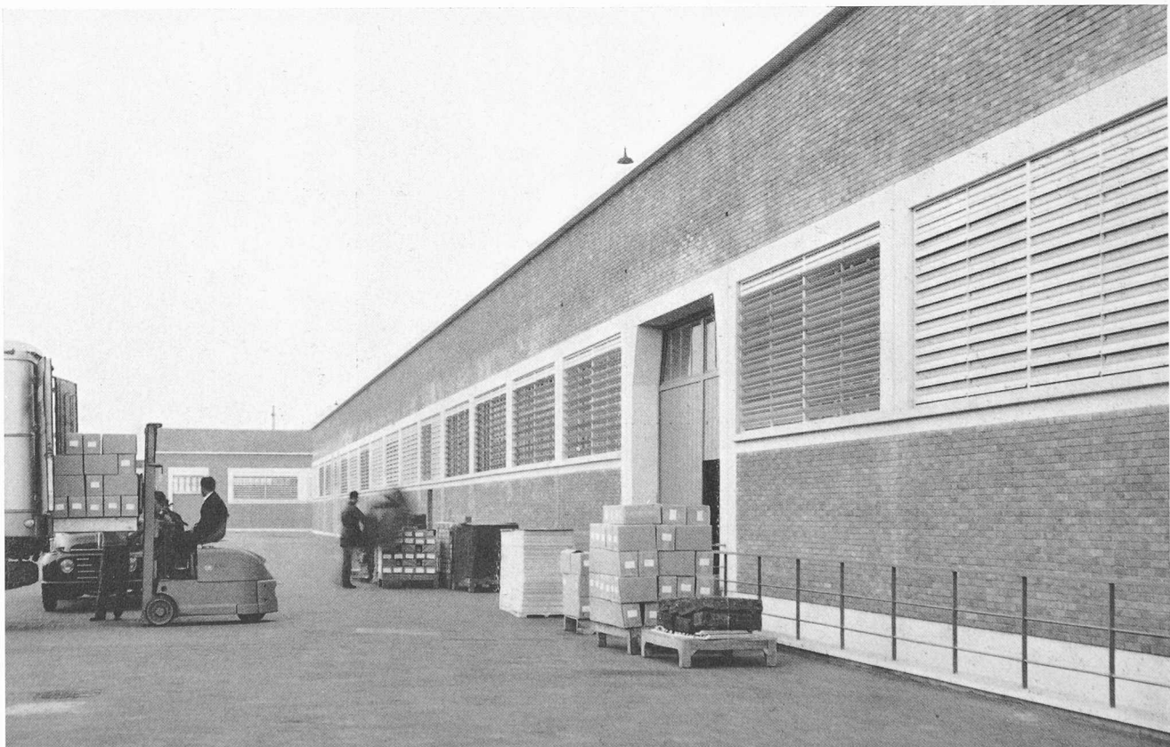
Seitenfassade mit Lamellenstoren
