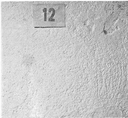
Nr. 12: Schalung ungehobeltes Holz, geölt. Plafonit haftet sehr gut
