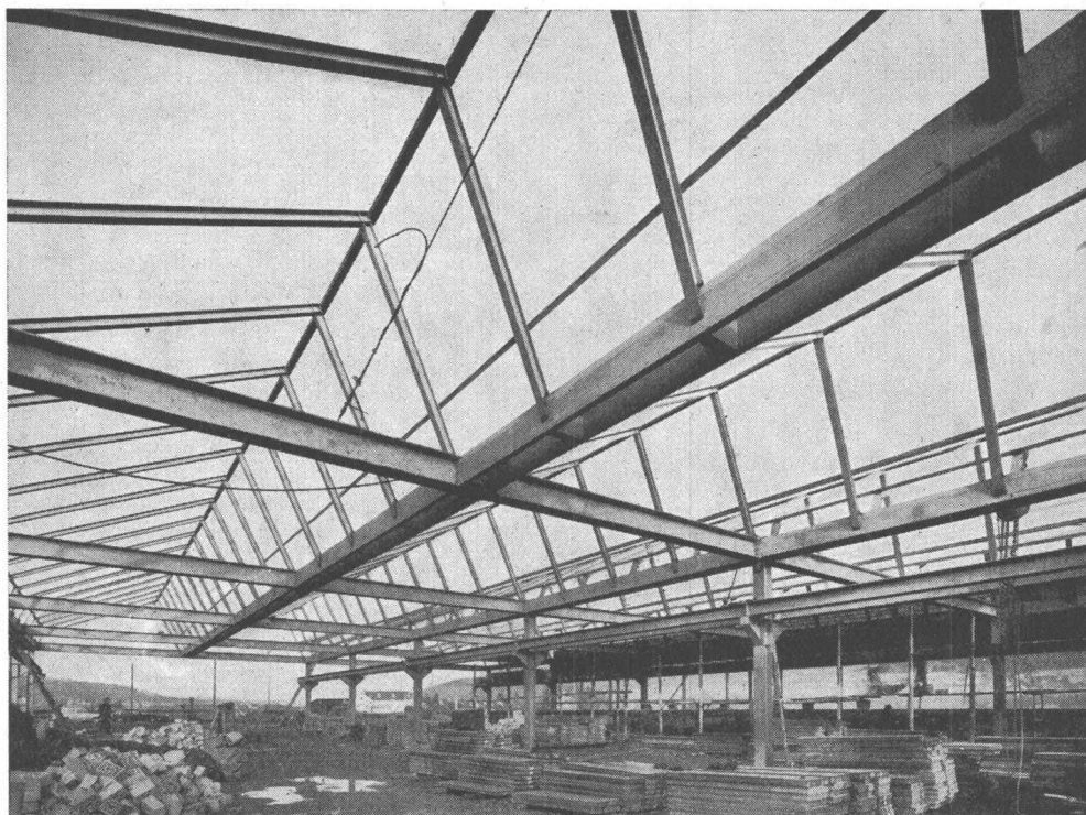
Shedbau, vollständig geschweisst
