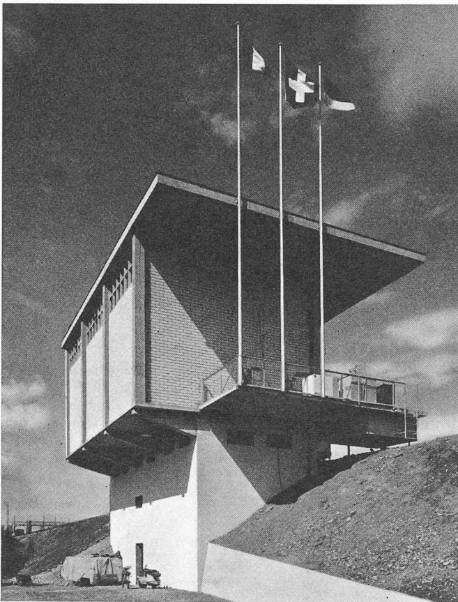
Bild 1. Das Gebäude der Eiszerzeugungsanlage am Bahndamm beim Badischen Bahnhof Basel
