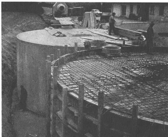
Betonbehälter für Heizöl, Inhalt 500 000 Lt.
