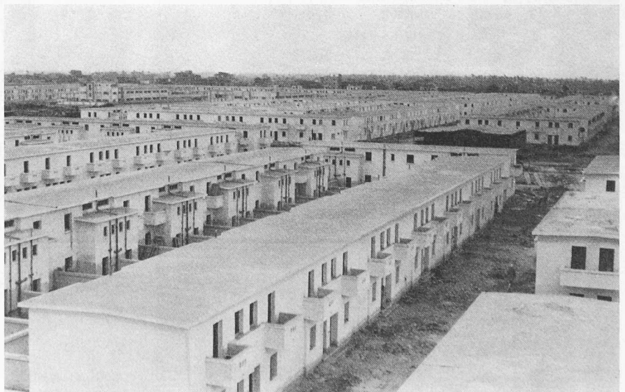
Bild 7. Embaba, eine vom Staat erstellte Neusiedlung ausserhalb Kairos, umfassend 2200 Reiheneinfamilienhäuser, jedes mit einem kleinen Gartenhof
