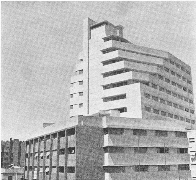
Bild 4. Die oberen Stockwerke dieses schief zur Strasse stehenden Bürogebäudes in Kairo sind dem Baugesetz entsprechend parallel zur Strasse abgeschnitten
