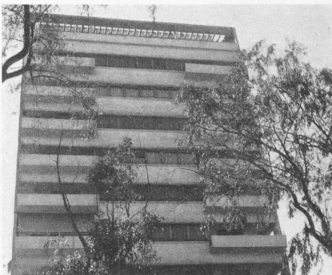
Bild 12. Wohnturm in Kairo: Eisenbetonskelettbau
