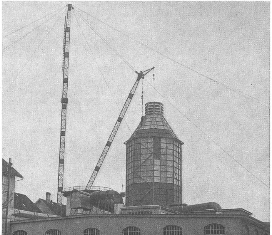
Abgasturm, Material: V 2 A + St. 37
