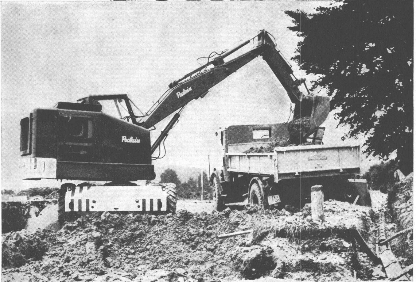
Unser Bild: Verladearbeiten im Strassenkoffer
